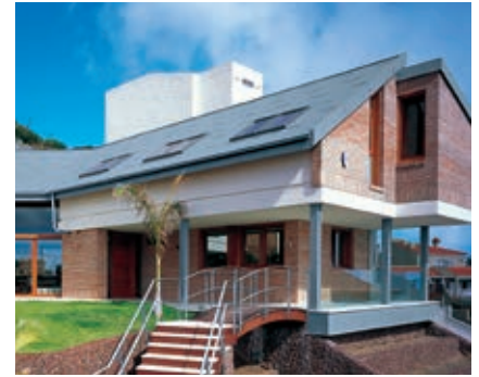
Wohnhaus Montaña del Socorro, Tafira Baja, Spanien
