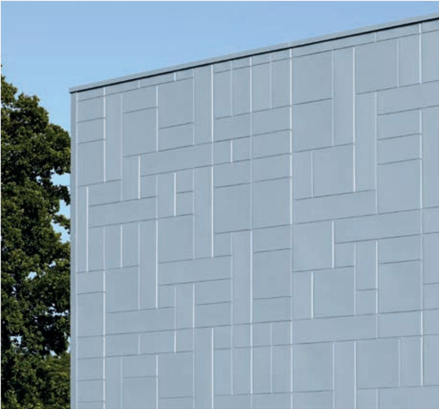
Fassadengestaltung mit „Wildem Verband“, Elemente von 250 mm bis 1000 mm
